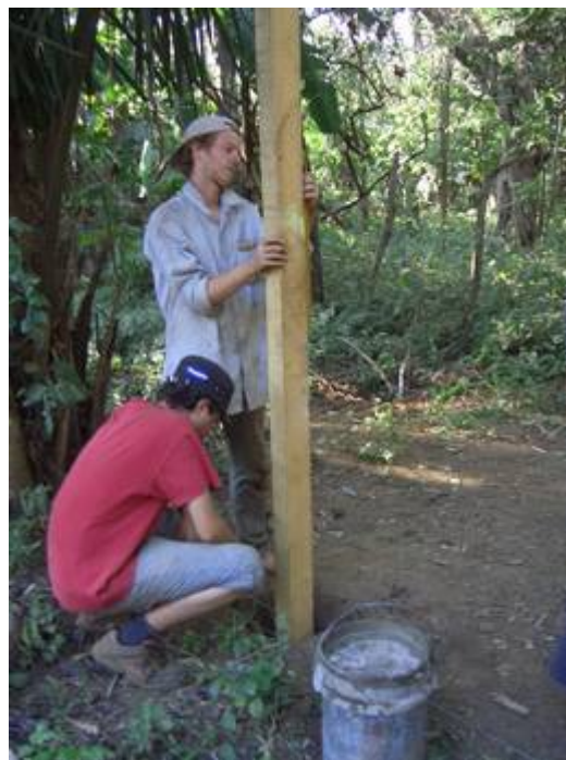
Bild: eine der tragenden Stelzen bekommt ihr Fundament
